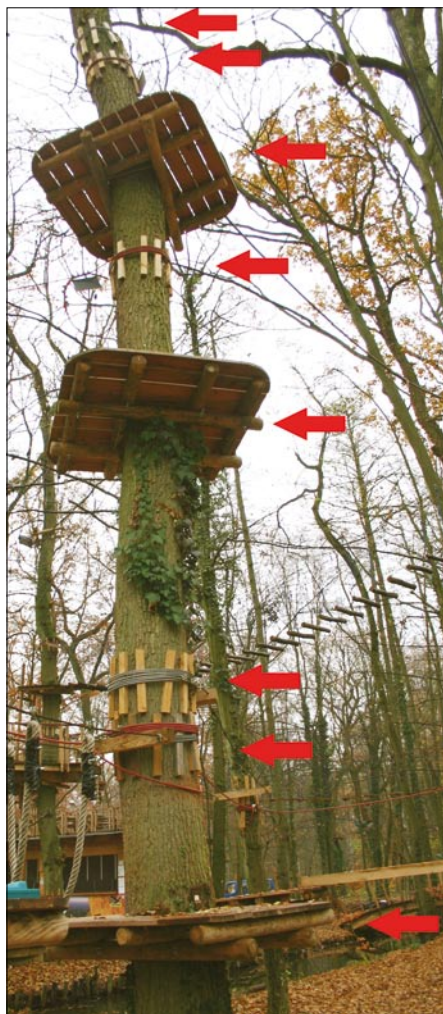
Abb. 1: Druckkraftebenen an einem Baum
