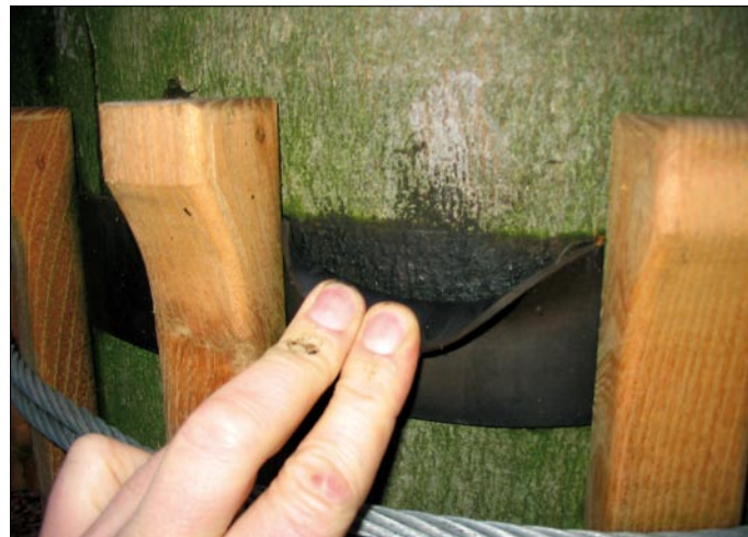
Abb. 6: Beginnende Rindennekrosen unter dem den Stamm umschließenden Gummiband der Abstandshalter eines Stahlseils
