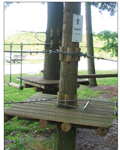
Abb. 4: Halbriegel als Abstandhalter zwischen Baum und ihm umschlingenden Seilen
