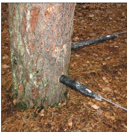
◀ Abb. 7: Kiefer mit eingebauten Stahlbolzen als Ankerpunkte zweier Balancierseile. Die Bolzen wurden vor etwa 5 Jahren installiert.
